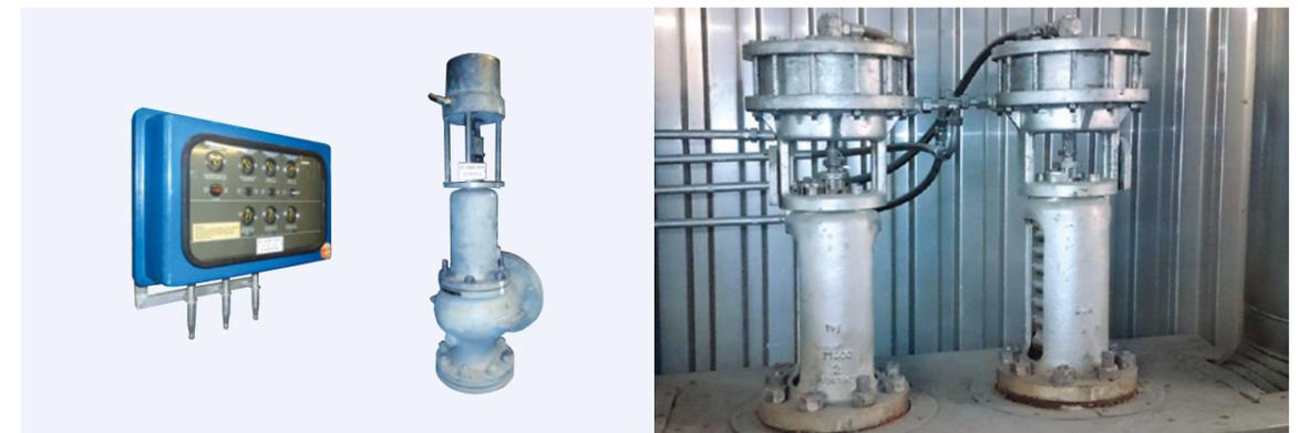
Ventile einer prüfbaren Steuereinheit PC 50 und PC 53
