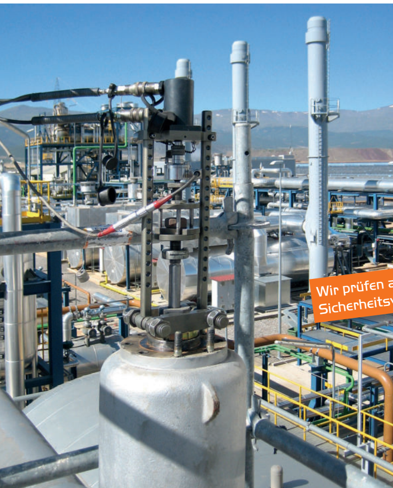
Sicherheitsventil mit Hubvorrichtung
